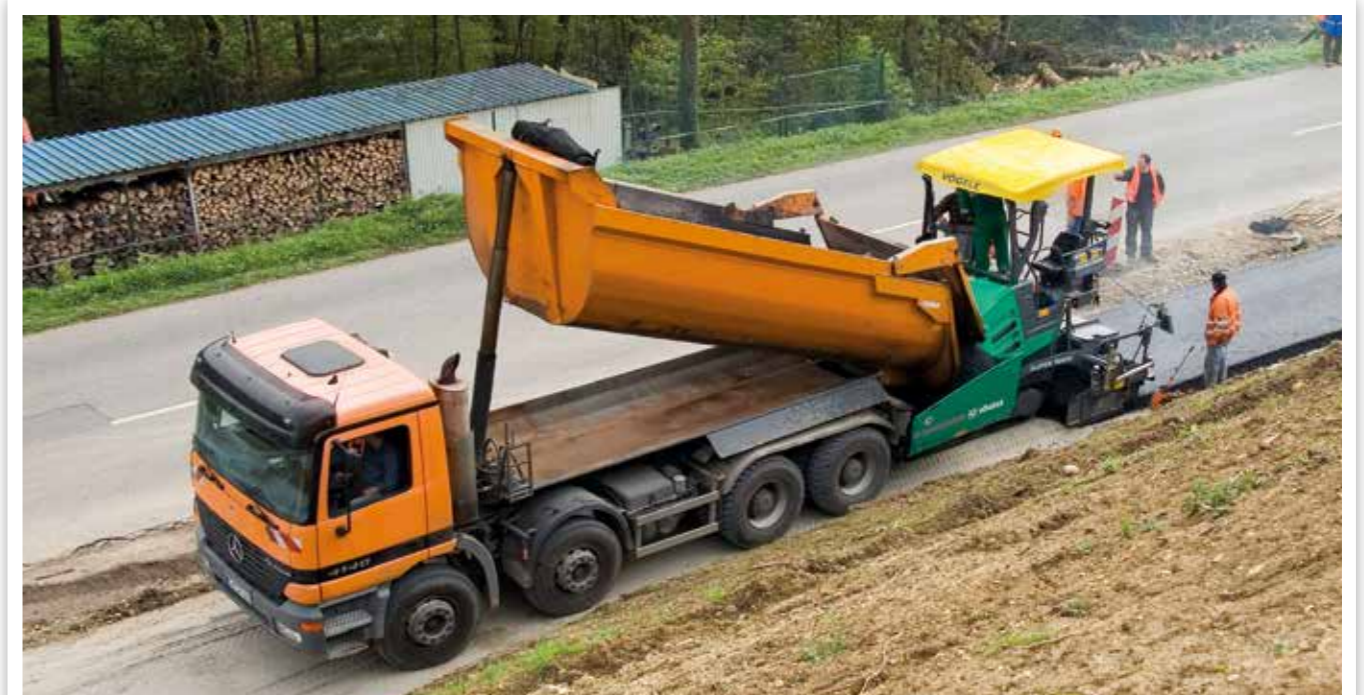
ASFALTATURA DI PISTE CICLOPEDONALI
