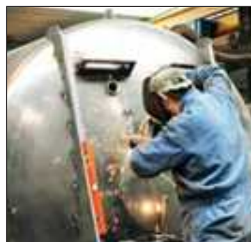
Soudure manuelle des accessoires
