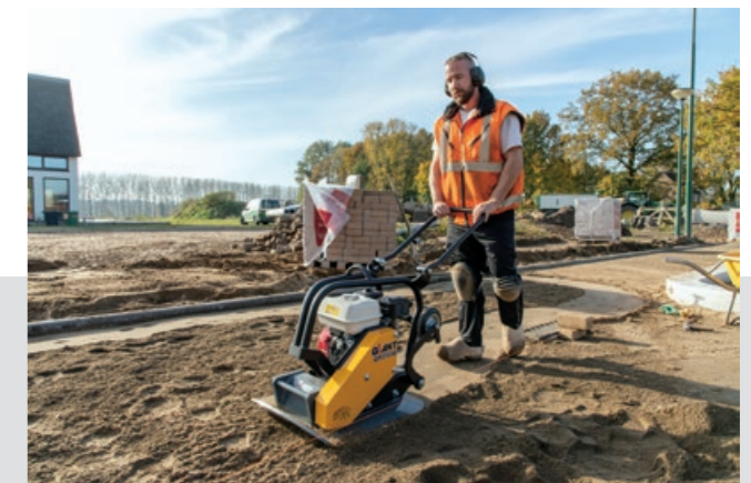
Präzises Arbeiten durch die speziell geformte Grundplatte
