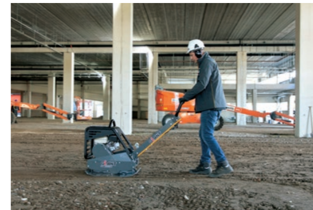
Die Arbeitsrichtung kann mit dem Haltegriff einfach eingestellt werden.
