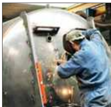
Soudure manuelle des accessoires
