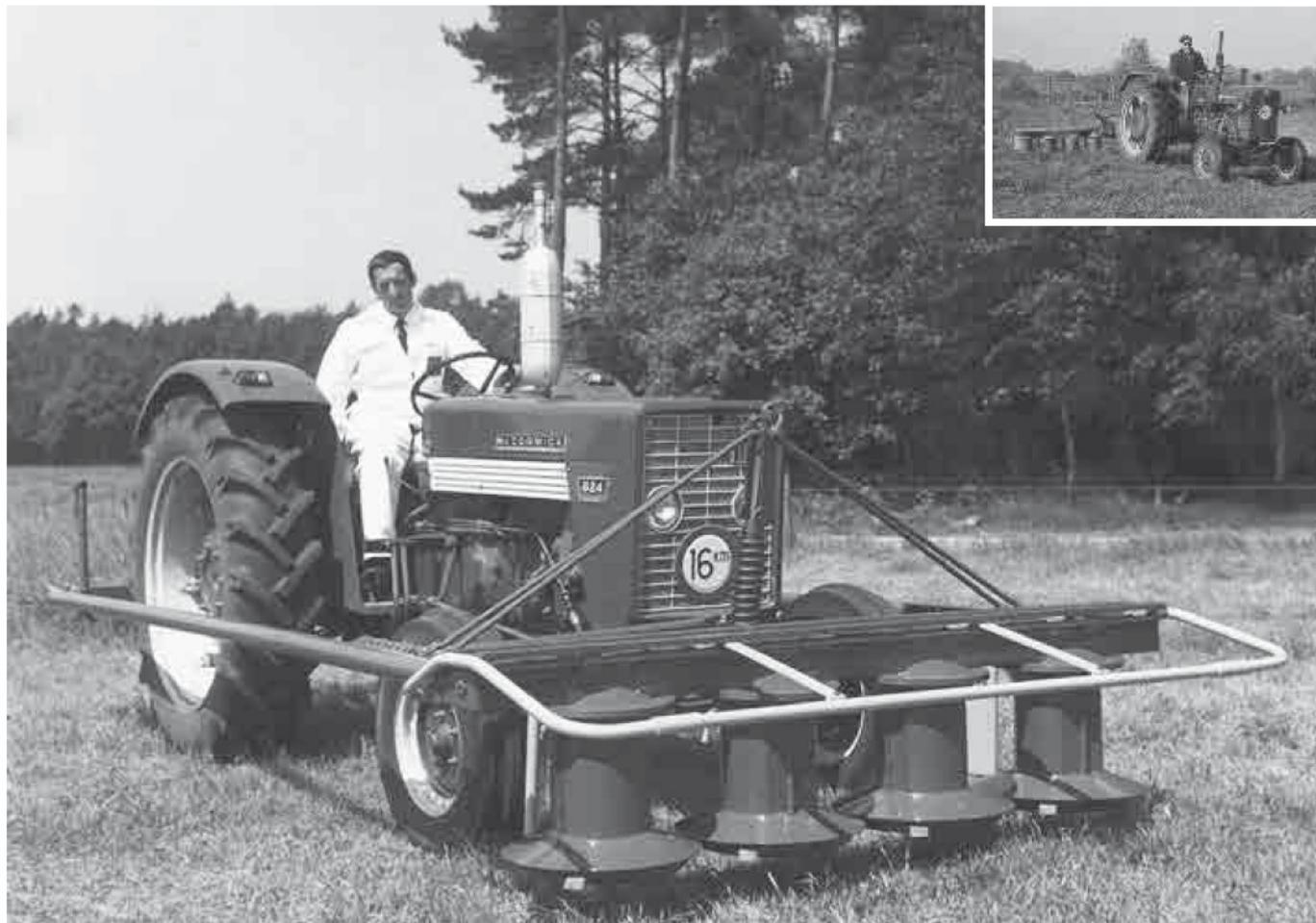
Um 1970 erfand Piet Zweegers auch ein Frontmäherwerk. Das Gerät war mit einer speziellen Vorrichtung vorn am Traktor befestigt und wurde von der hinteren Traktorzapfwelle aus angetrieben.
