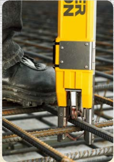
Schritt 4: Die Bewehrung wird eingebaut und mit Bewehrungsbinde- und schneidgeräten von Wacker Neuson verarbeitet.
