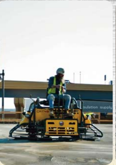
Schritt 8: Für eine feine und ebene Oberfläche kommen Flügelglätter zum Einsatz: Erst vorglätten, dann nachglätten und schließlich polieren.
