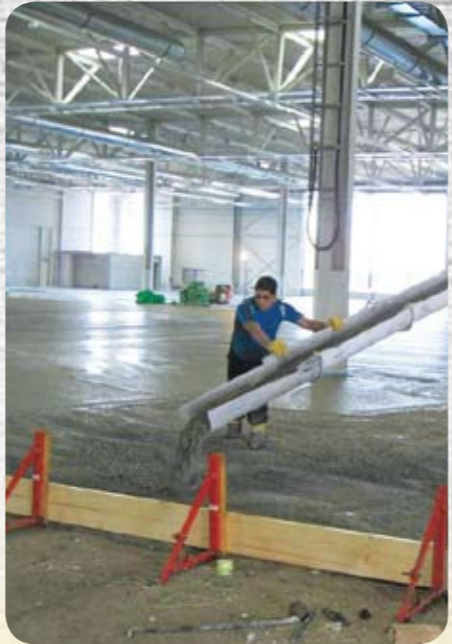
Schritt 5: Der Frischbeton wird angeliefert und eingebaut.
