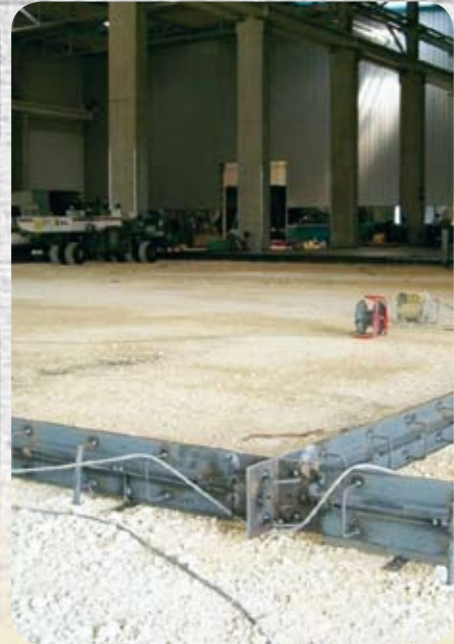
Schritt 3: Die Flächenbegrenzungen werden aufgebaut.
