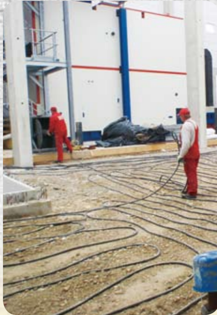
Schritt 1: Je nach Temperaturlage, muss der Boden vor dem Bearbeiten aufgetaut und erwärmt werden. Der E 700 M von Wacker Neuson ist dabei der ideale Prozessbeschleuniger.
