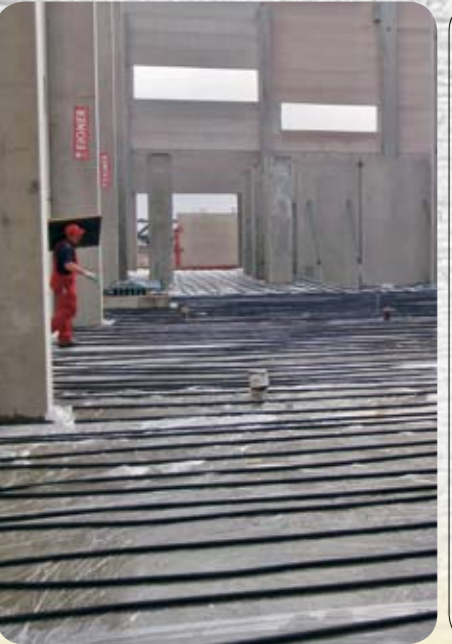
Schritt 9: Das Nachbehandeln verhindert ein zu schnelles Abkühlen und Austrocknen des Betons während des Erhärtens. Ideal geeignet für diesen Prozess ist der Flächenheizer E 700M von Wacker Neuson, da er einen stabilen Abbindeprozess durch seine flächendeckende Heizkraft garantiert.
