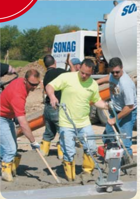
Schritt 7: Mit der Abziehböhlle wird sichergestellt, dass die Betonfläche eben ist und die geforderte Höhe eingehalten wird. So ist der Boden optimal für den Einsatz der Flügelglätter vorbereitet.
