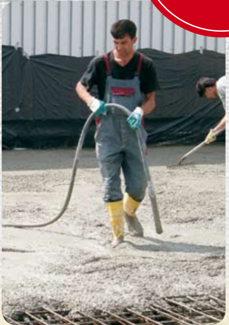
Schritt 6: Anschließend sollte der Beton verdichtet werden. So erhält er eine erstklassige Qualität. Dazu bietet sich das große Sortiment an Innenvibratoren von Wacker Neuson an.
