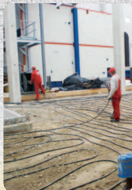
Стъпка 1: В зависимост от температурата, почвата трябва да се размрази и стопли преди да се обработва. E 700M на Wacker Neuson е идеалният ускорител на процеса.
