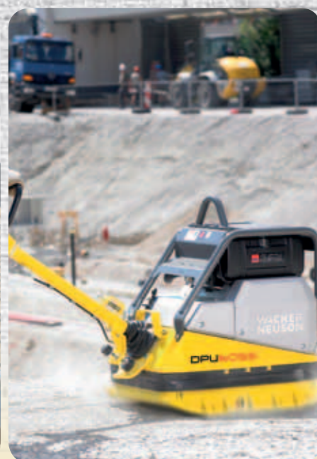
Стъпка 2: Почвата се подготвя и се уплътнява преди да продължи обработването. В зависимост от площта Wacker Neuson предлага широк асортимент от вибрационни плочи.
