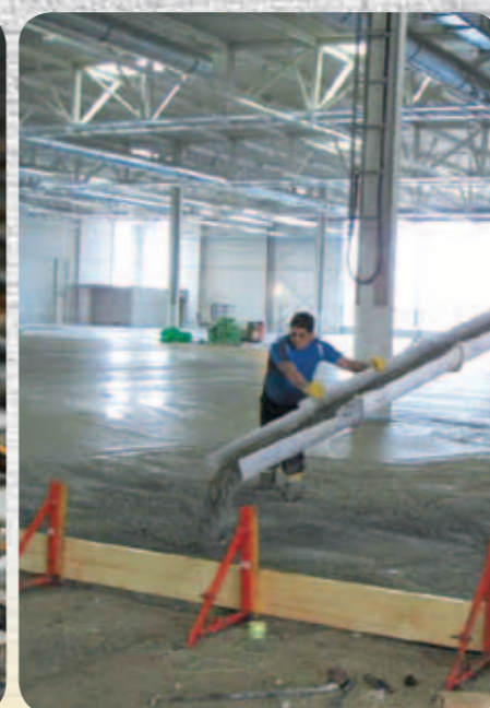
Стъпка 5: Пресният бетон се доставя и се залива.
