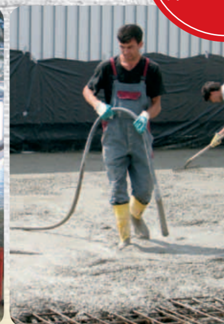
Стъпка 6: След това бетонът се уплътнява. Така той получава изключително високо качество. Едновременно с това се предлага и широк асортимент от иглени вибратори на Wacker Neuson.
