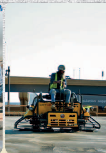
Стъпка 8: Роторните заглаждачи се използват за фина и равна повърхност: първо се прави предварително заглаждане, след това се дозаглажда и най-накрая се полира.
