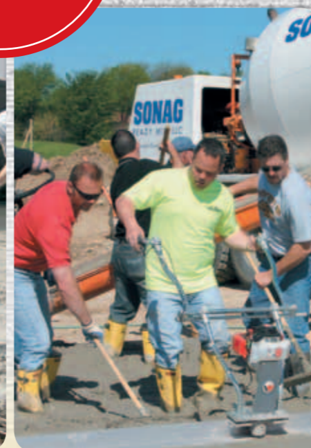
Стъпка 7: Благодарение на изтеглящата виброрейка се гарантира, че бетонната повърхност е гладка и се спазва необходимата височина. Така подът е оптимално подготвен за използване на роторните заглаждачи.
