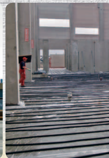
Стъпка 9: Допълнителното обработване предотвратява бързото охлаждане и изсъхването на бетона по време на втвърдяване. Изключително подходящ за този процес е площният отоплител E 700M на Wacker Neuson, тъй като гарантира стабилен процес на втвърдяване благодарение на топлинната си мощност, която обхваща цялата повърхност.
