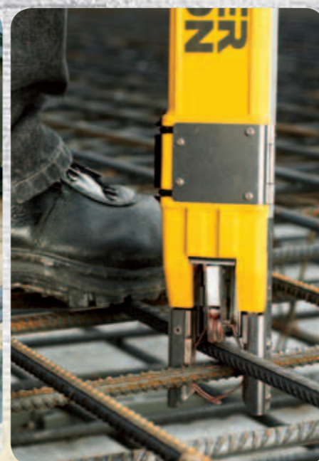
Стъпка 4: Поставя се армировката и се обработва с връзващите и режещи механизми на Wacker Neuson.
