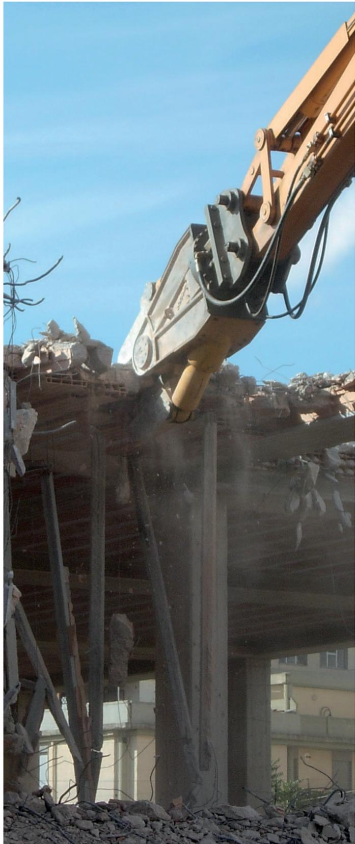
Rotazione idraulica continua a 360°, con valvola di protezione, che permette una demolizione migliore in tutte le condizioni logistiche e una presa sempre ottimale del materiale da demolire
