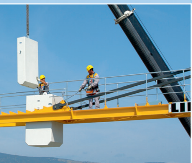
Gleichzeitiges Ballastieren und Einscheren des Hubseils sichert Zeitvorteile.
