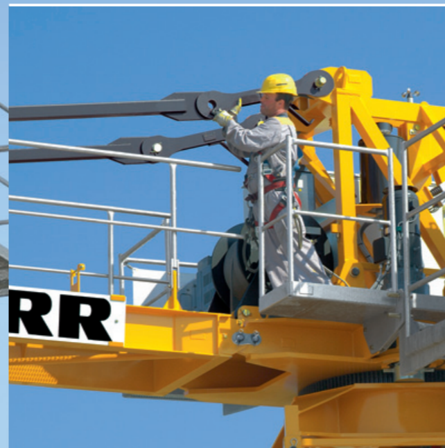
Schnelle Verbolzung der Gegenausleger-Abspannungen.
