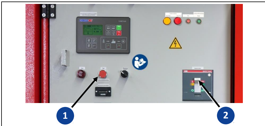
Abb. 6-5 Differenzstromauslöser
