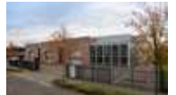
Nieuwe fabriek voor de productie van de Tulip akkerbouwlijn wordt in Etten-Leur in gebruik genomen
