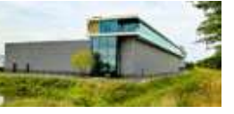
Nieuwe fabriek voor de productie van Pitbull en Biga Topliner wordt aan de Patagonweg in Etten-leur in gebruik genomen
