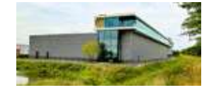
Une nouvelle usine de production de chargeurs compacts Pitbull et de Biga Topliner est mise en service sur le Patagonweg à Etten-leur
