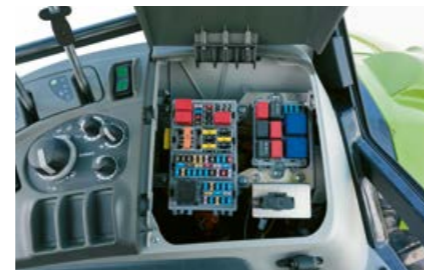
Bezpieczniki umieszczono centralnie w kabinie.
