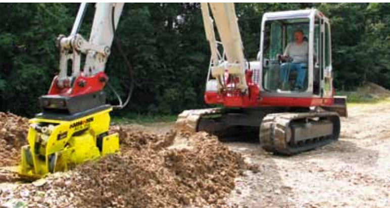
ACA 350 ohne Drehvorrichtung im Kanalbau
