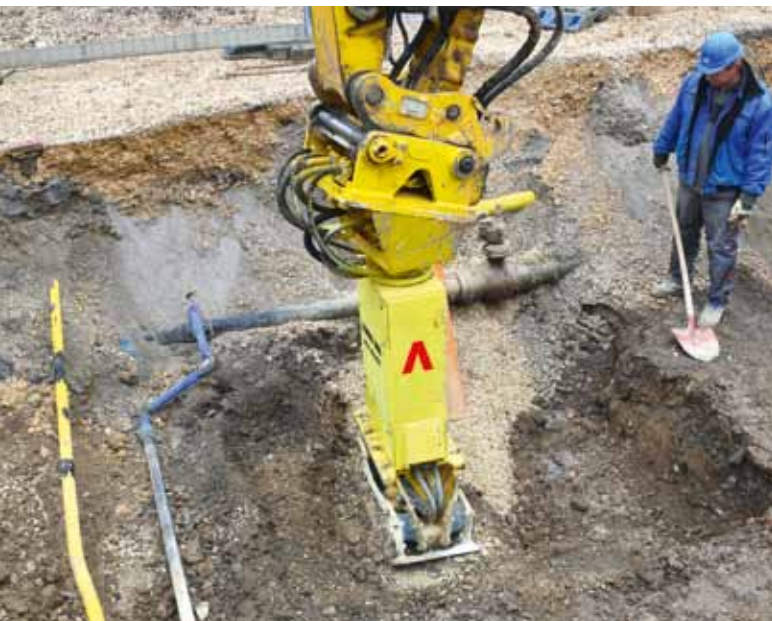
ACA 350-RE mit verlängertem Oberteil für den Einsatz in tiefen Gräben
