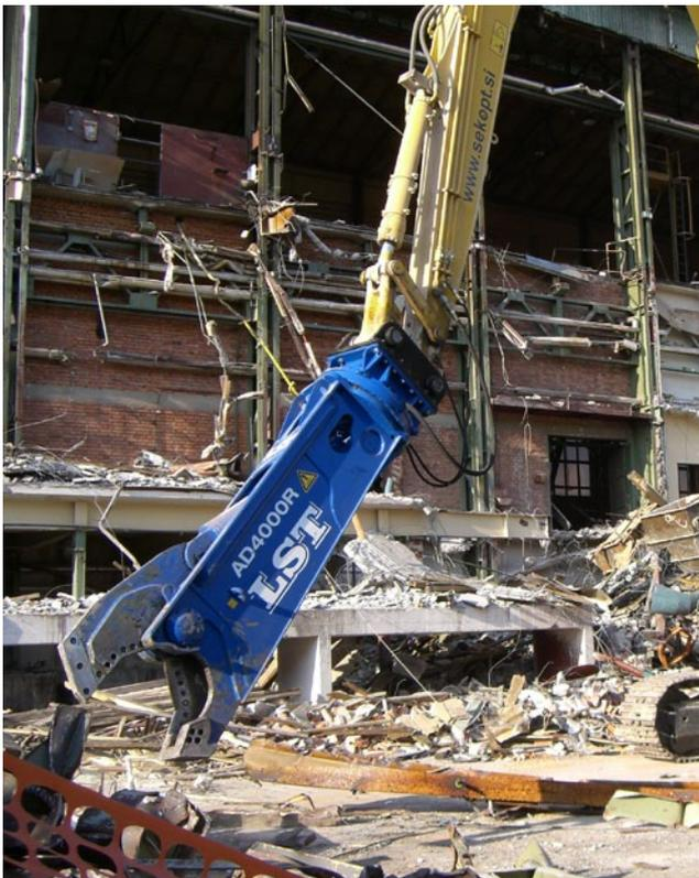
Der schlanke Grundkörper und der obenliegende LST HWRI Drehantrieb sorgen für die besonders gute Positionierbarkeit der Serie AD. Mit von außen einstellbarem Scherenspiel und wendbaren Messern sind die Modelle wartungsfreundlich und erreichen lange Standzeit und reduzierte Verschleißkosten. Das Eilgangventil bewirkt hohe Schließgeschwindigkeiten und hohe Produktivität.
