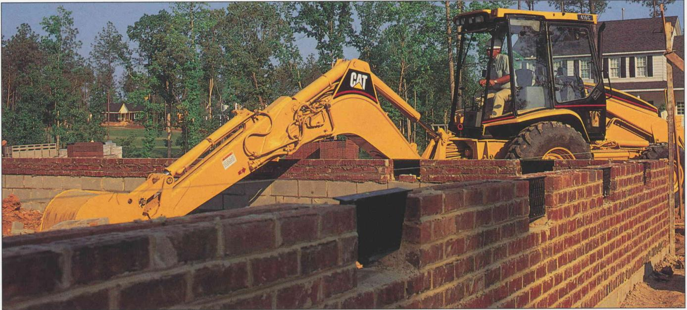
**Hydraulique.** Comme on ne travaille pas toujours à plein régime, le système hydraulique à débit variable peut capter la charge de travail pour ensuite régler le débit et la pression en conséquence. Un tel dispositif fournit une grande puissance de creusement, quel que soit le régime moteur, ce qui assure une grande maîtrise des opérations pour les travaux délicats entrepris dans des espaces restreints. Et, plus important encore, cela prolonge la durée de vie du système.
